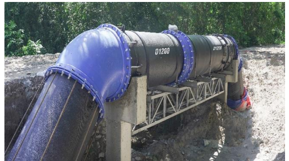
Tuyến ống nước thô D1200mm NMN Chơn Thành
