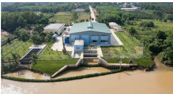
Trạm bơm nước thô NMN Tân Hiệp
