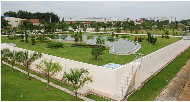
Bể chứa nước sạch 7000m 3 của nhà máy nước Dĩ An
