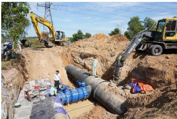
Thi công tuyến ống nước sạch D1500mm cho khu vực Thành phố mới Bình Dương và Tx. Bến Cát
