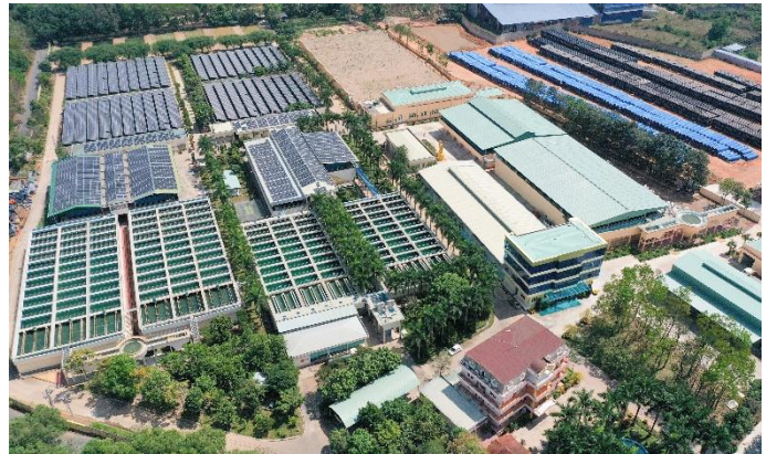
Nhà máy nước Tân Hiệp công suất 600.000 m 3 / ngày đêm
